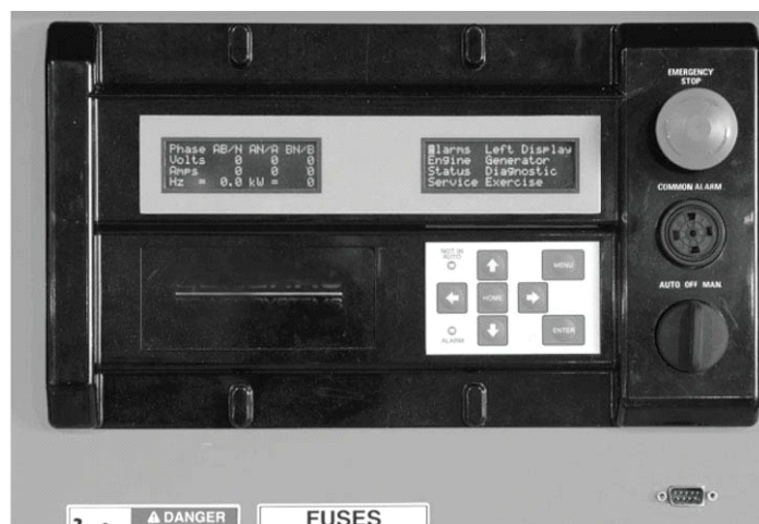
РИСУНОК 3-2. Интерфейс панели управления H-100
